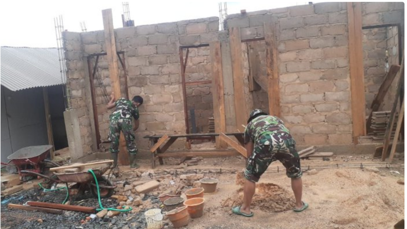
Satgas TMMD Ke 116 Kodim 1004 Kotabaru Genjot Pembangunan Tempat Wudhu Di Musholla
